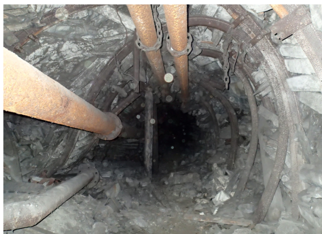
Рис. 6. Состояние ходка механической доставки 3-й ступени пласта k_8 шахты им. Челюскинцев
